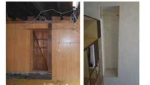
改修前 改修後 洋服掛け
